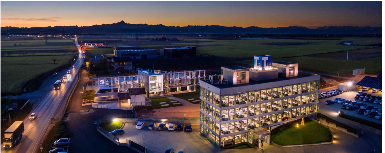
Le siège de Tesisquare S.p.A., à Roreto di Cherasco (Italie)
